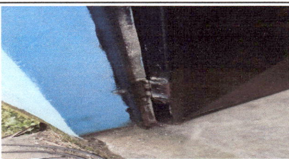
Foto 12: se procedió a la reparación de la puerta para que se pudiera cerrar y abrir sin dañar más el marco de la puerta, pues se tenía dificultades para poder cerrar.
