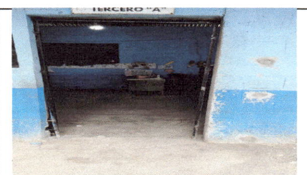
Foto 10: se cambió el marco derecho que era de madera, se mejoró el marco, las bisagras con soldadura y se mejoró el lugar del candado.
