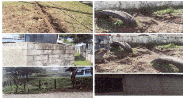
Foto 8: El depósito de agua No2. se revisó la tubería que abastece al establecimiento y se encontró el tubo dañado donde se iba el agua de la pila, se procedió al cambio de tubería además se colocó un sistema de
