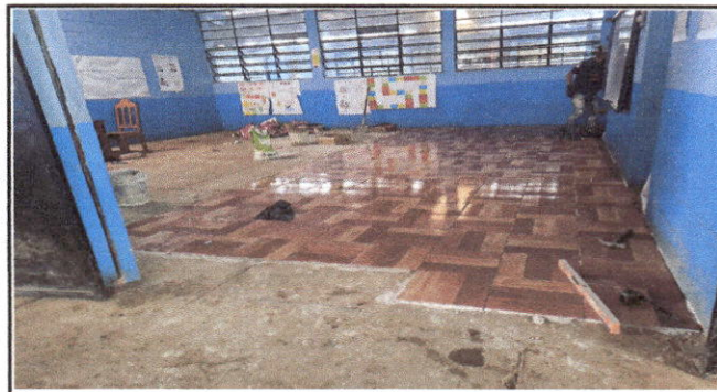
Foto 4: piso del Aula 4 Segundo C, se rellenaron agujeros, se niveló el piso y se colocó piso cerámico en el aula, espacio de la bodega de sillas y tienda que está en un espacio dentro del aula.
