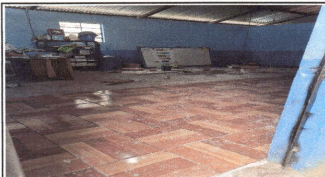
Foto 3: Piso del aula 3 Segundo B se llenaron los agujeros que estaban en el piso, se niveló y se colocó piso cerámico.
