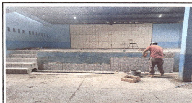
Foto 6: en el escenario se procedió a colocar azulejos en el fondo, se forraron las gradas, se cambió de lugar unas gradas que obstaculizaban el paso y se forraron con piso antideslizante.
