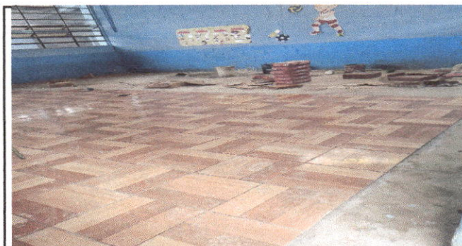
Foto 5: piso del aula 5 Primero B, se rellenaron agujeros con concreto, se niveló el espacio y se procedió a la colocación del piso cerámico.
