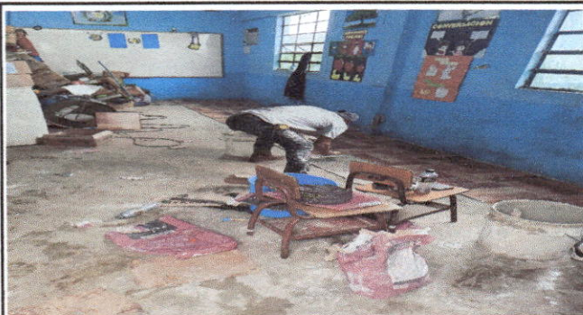
Foto 1: El Aula 1 de Párvulos 2 Sección A. Se niveló el piso y se procedió a la colocación de piso cerámico.
